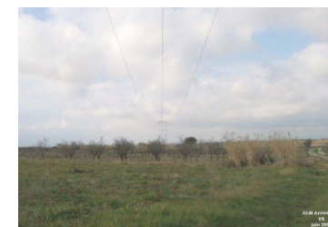
Ligne haute tension
